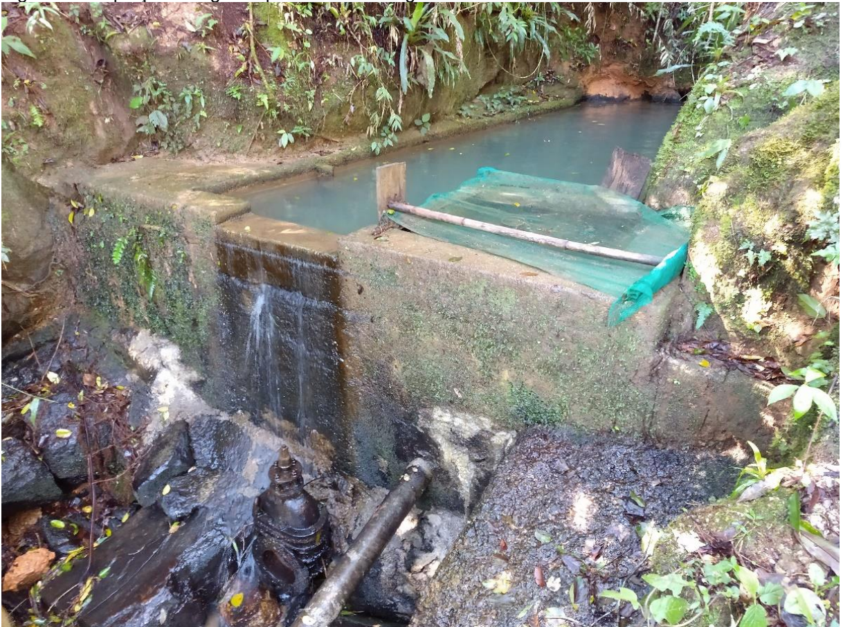
Figura 17: Captação de água superficial no Rio Água Fria.
