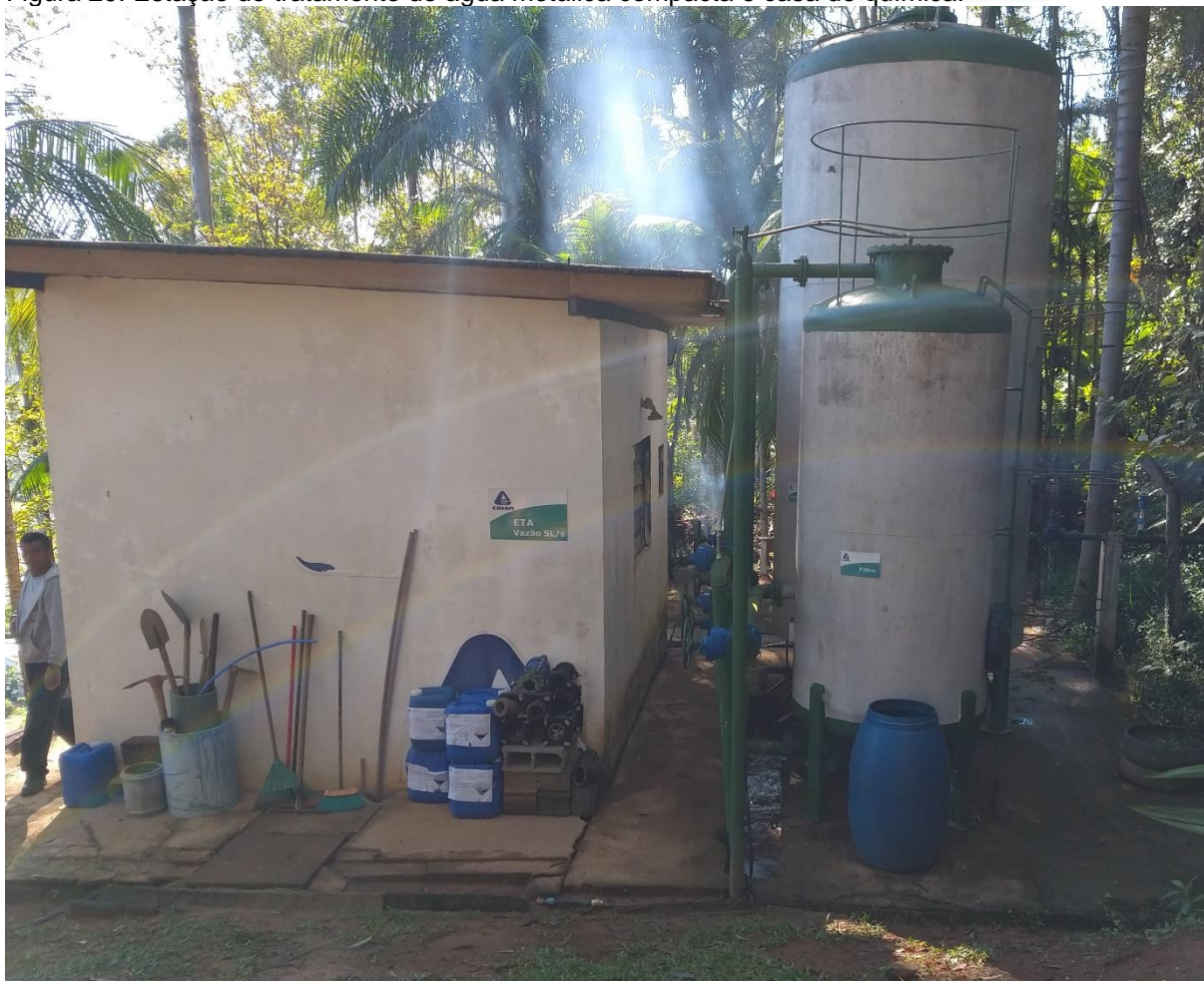
Figura 20: Estação de tratamento de água metálica compacta e casa de química.
