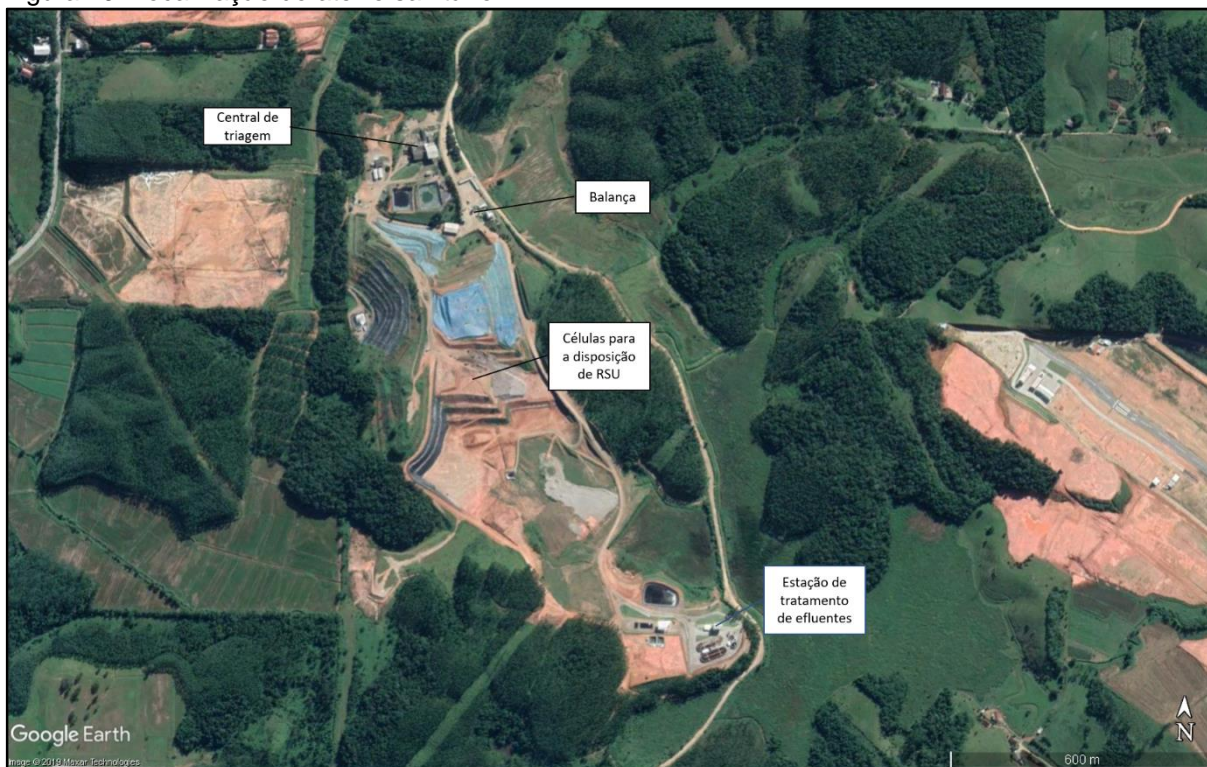
Figura 29: Localização do aterro sanitário.
